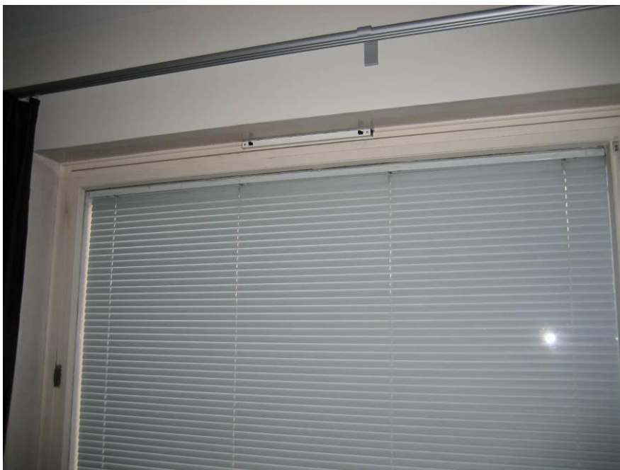
Figur 2 Spaltventil ovanför fönstret
