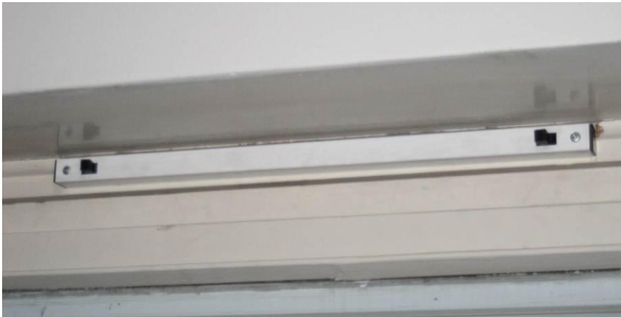
Figur 3 Stängd ventil (spakarna inåt)
