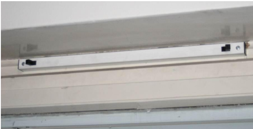
Figur 4 Öppen ventil (spakarna utåt)
